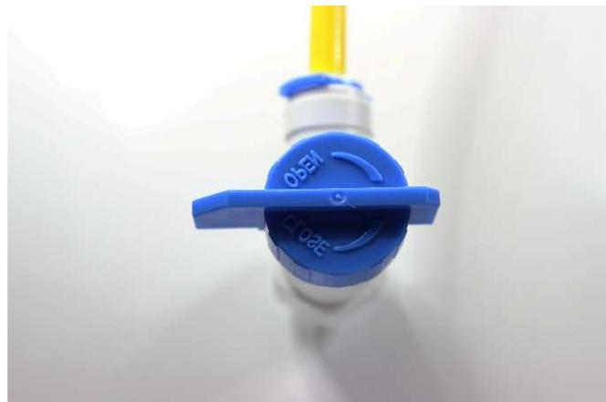
Avant de brancher l'équipement à l'entrée d'eau du réseau, vous devez noter que 2 vannes d'alimentation sont fixées à l'équipement, une 1/2" et une 3/8". Ces robinets ont été conçus pour servir de pont entre la vanne carrée pour l'alimentation en eau habituelle dans les installations de cuisine. Si vous ne disposez pas de ce type de connexion, vous devrez apporter les modifications nécessaires pour pouvoir vous connecter.
